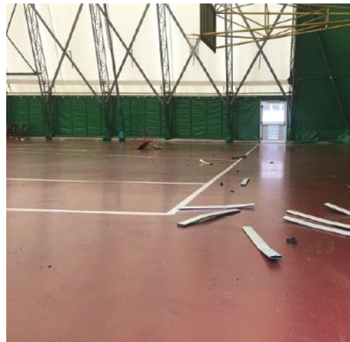
La tensostruttura dell'Omni, più volte fatta oggetto di vandalismi, dove sorgerà il nuovo palazzetto dello sport di Vimercate
