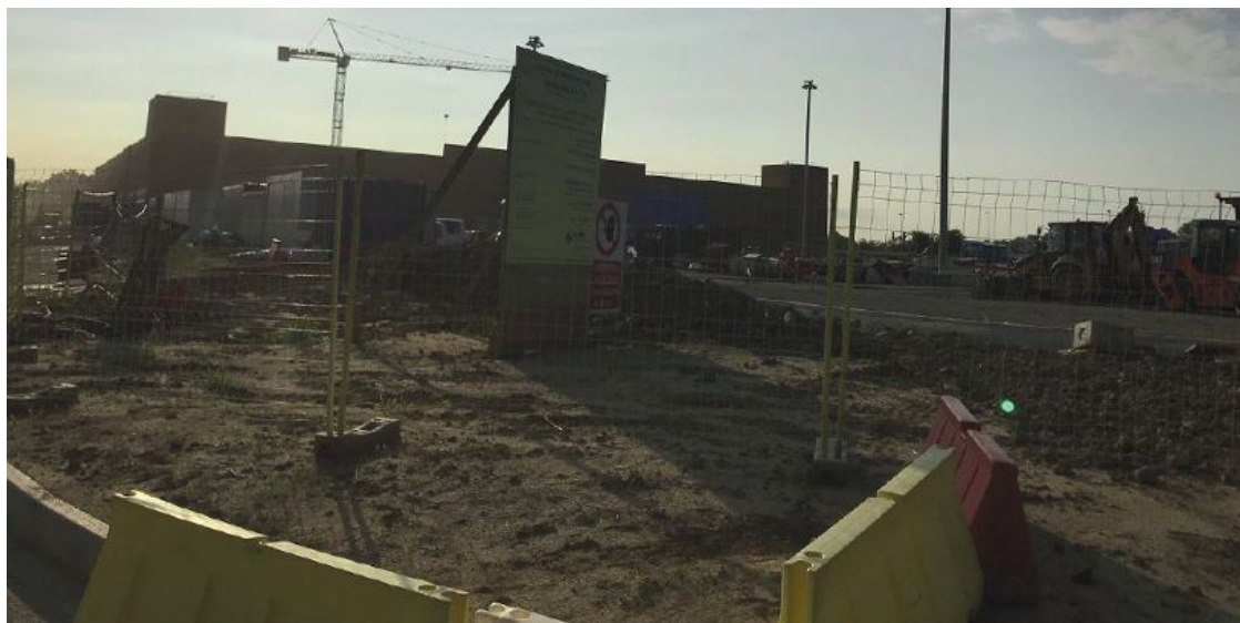
Il cantiere della nuova Esselunga di Vimercate
