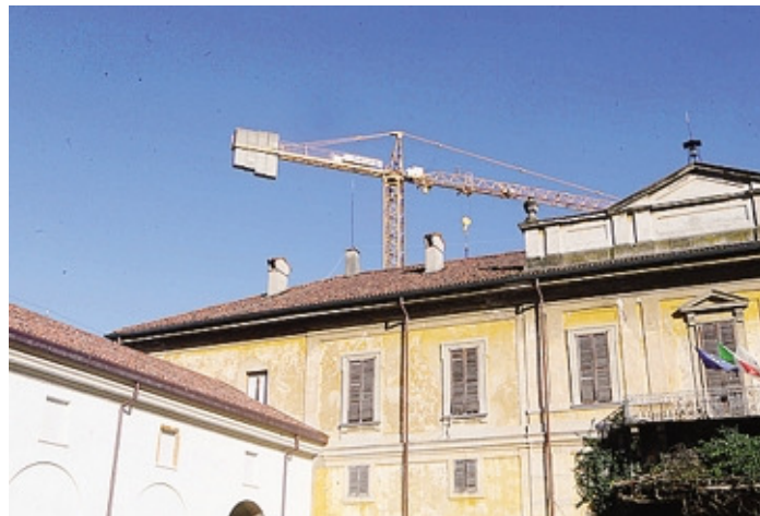
Villa Sottocasa all'epoca dei lavori
