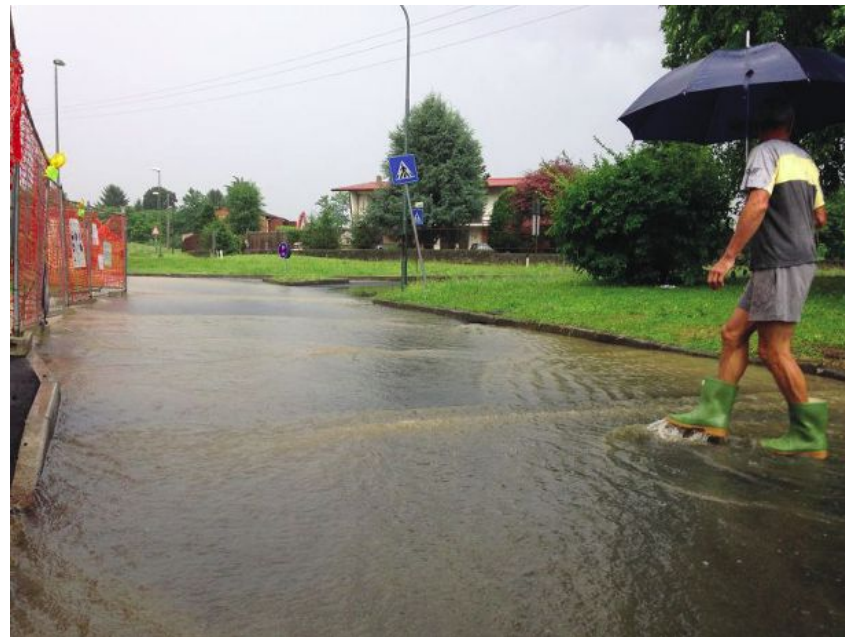
Un tratto di via Indipendenza, a Ruginello, nei pressi del cimitero, finito ripetutamente sott'acqua
