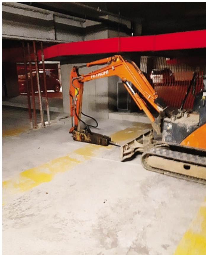
I lavori in corso al sistema trave-pilone che ha ceduto prima di Natale Foto Prada
